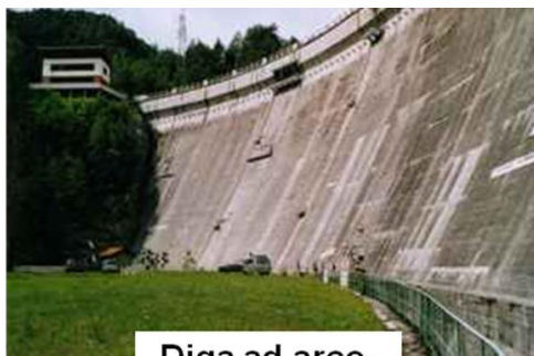
Diga ad arco-gravità
