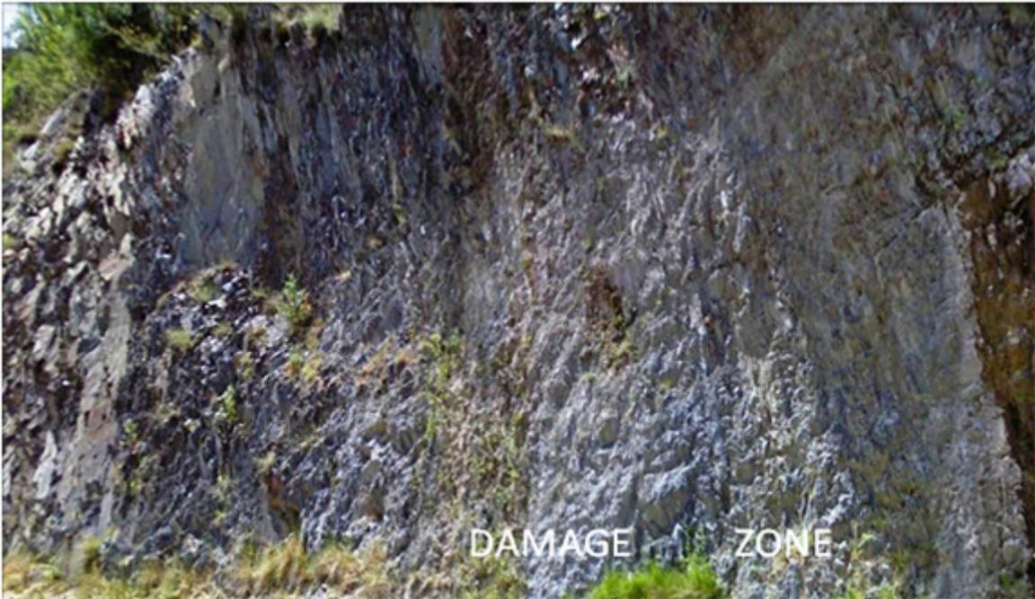
**Fig. 4 - Damage zone con fratture in diverse direzioni e venute d'acqua lungo le discontinuità più aperte**
