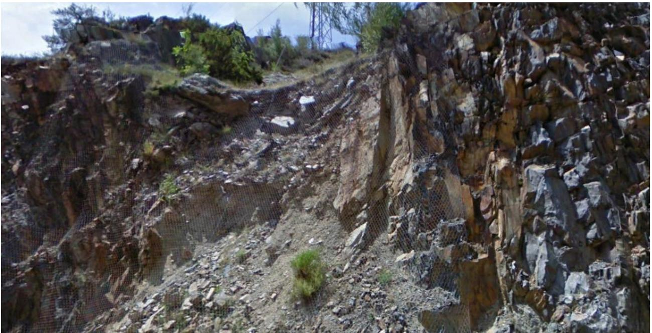
**Fig. 11 - Gouge e damage zone con più di un sistema di discontinuità , che hanno luogo ad aperture elevate**
