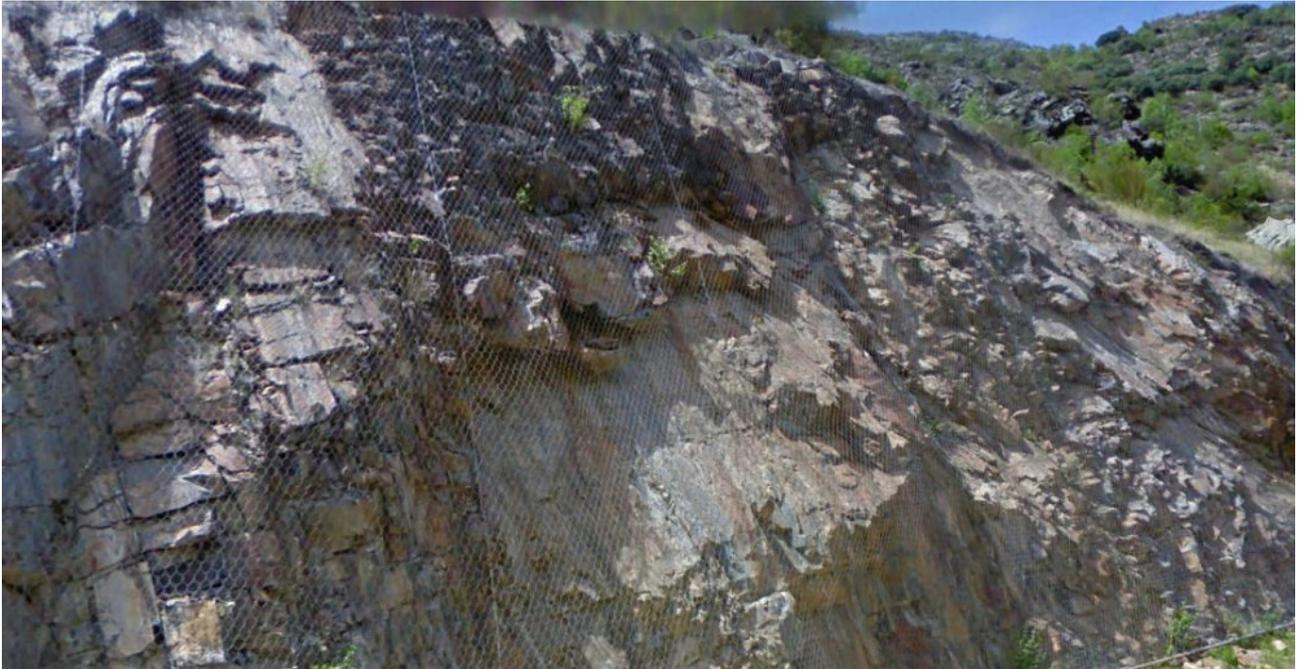
**Fig. 19 - La presenza di scaglie evidenzia lo scorrimento delle rocce circostanti, con produzione di livelli a fratturazione minuta e dilatazione delle aperture della DZ**
