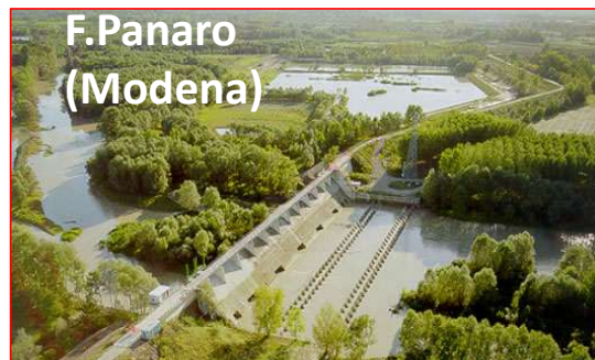
Figura 42 - Esempi di casse di espansione: sono quelle di Renai in provincia di Firenze, e quelle sul F. Secchia e sul F. Panaro in Emilia Romagna
