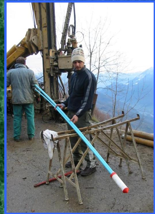
monitoraggio dei livelli di falda per individuare le sottopressioni che **peggiorano le condizioni di stabilità** del pendio
