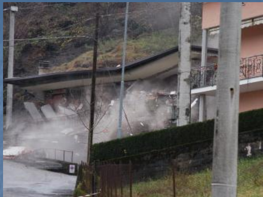
La casa viene colpita dalla frana
