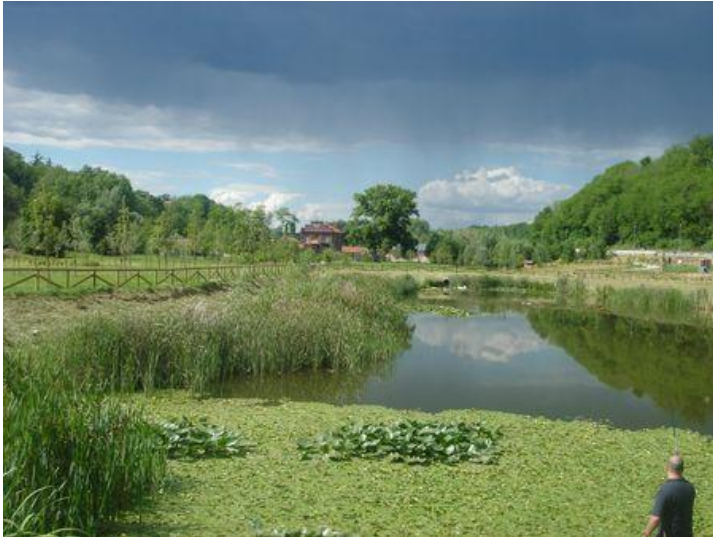
Sistema di fitodepurazione a flusso libero superficiale a Dicomano in provincia di Firenze (foto Iridra, Firenze).
